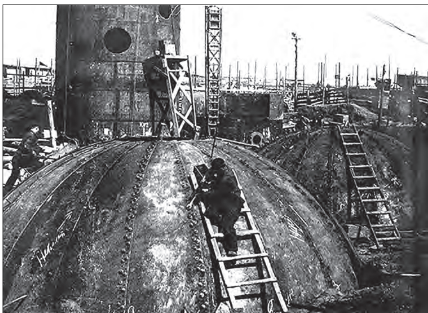
Магнитогорский металлургический комбинат. Строительство домны №1. Сборка купола каупера. 16 августа 1931 г
